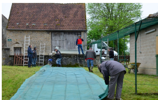
Installation des bâches
